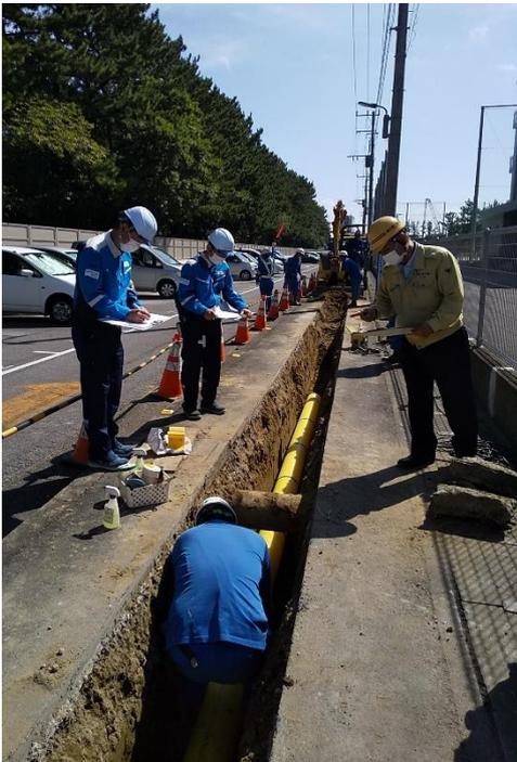
ガス本管（PE200A）敷設現場の検査
