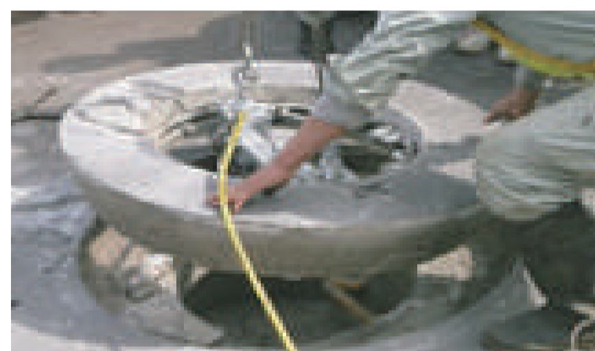
破碎は行わず吊り上げ
