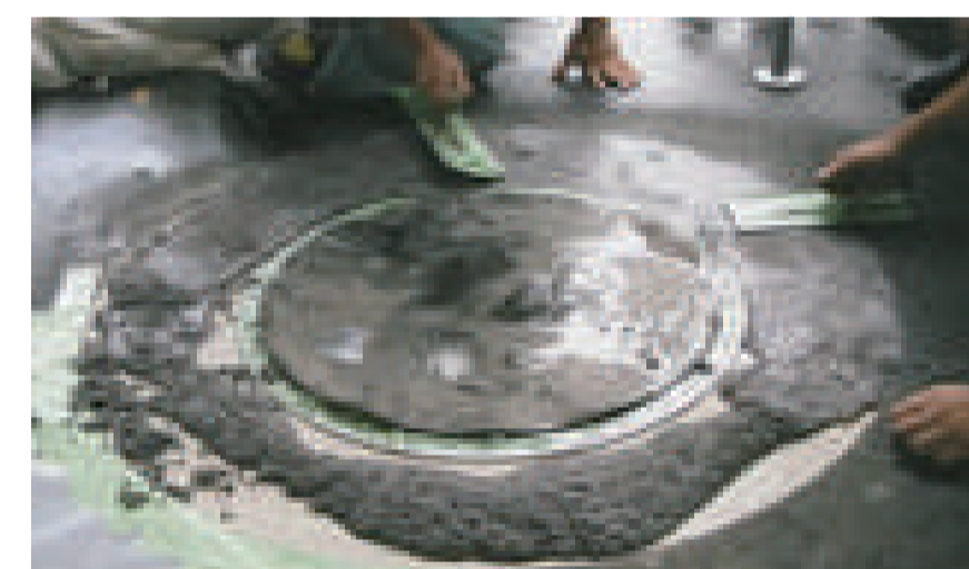
充填材、表層材共に無転圧で施工
